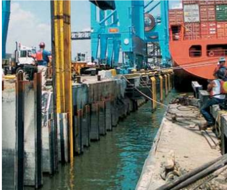
Fotografía 13. Muro de contención combinado, perfiles en H y tablestaca metálica.
